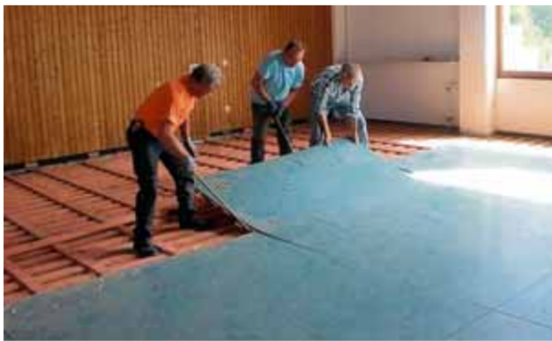
In Eigenleistung bauten die Tanzsportler auch einen neuen Parkettschwingboden ein. Foto: Hittinger
